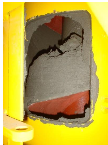
ケーシング内部
